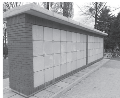
Kolumbarium na cmentarzu przy ul. Katowickiej.
